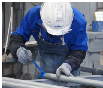
整備が完了した部材にマーキング
